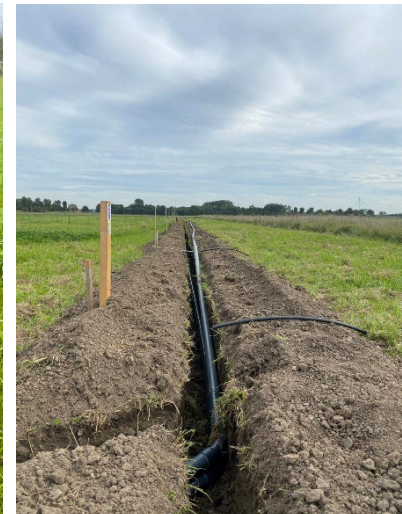
Links: jonge bomen worden met kokers beschermd tegen vraatschade door reeën en hazen. Rechts: het druppel-irrigatiesysteem in aanleg.
